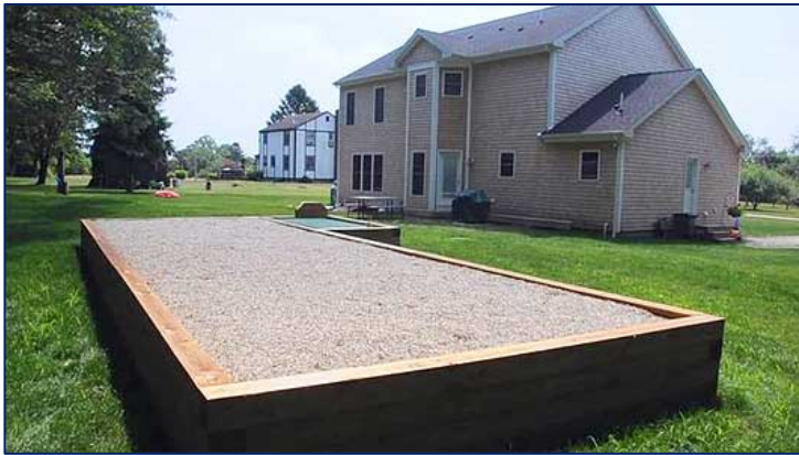
Recirculating sand filter, courtesy: AJFoss.com
